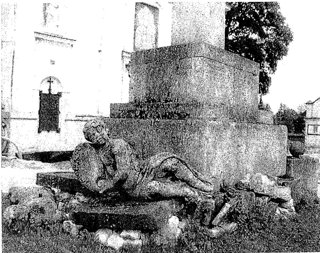
Fot 1. Stan obiektu ok. roku 2000 -w czasie remontu obejścia wokół kościoła . Elementy dolne w tym rzeźby poprzemieszczane , rozbite, podmurówka murowana -popękana. Fot archiwum parafii.
